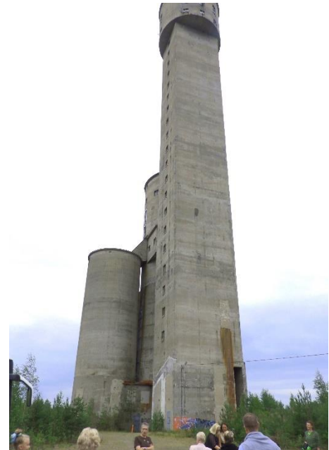
Keretin 96 m korkea kaivostorni.
